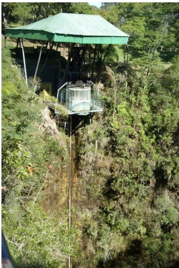
Figura 03 – Furna Um e o elevador, atualmente desativado. Fonte: Autores.
