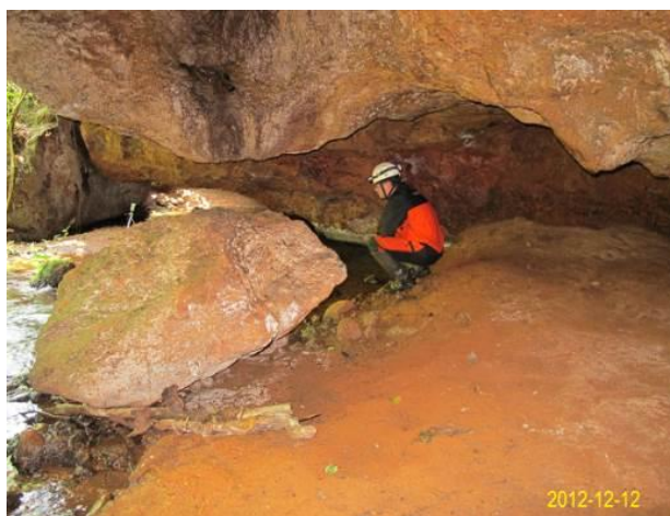
Figura 5 – Exemplo de perfil de cavidade em contato canga/minério onde pode ter ocorrido erosão nas bordas da drenagem.
